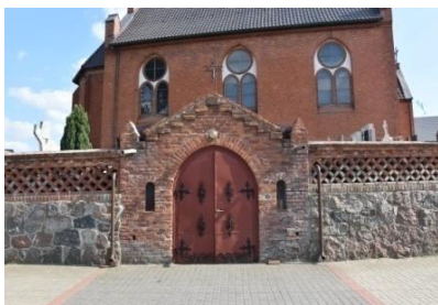
Fot. 2. Dąbrówka. kostnica przy kościele parafialnym (fot. autor).
