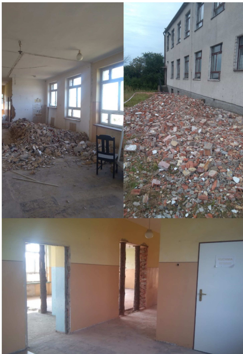
Rysunek 8 Budynek byłej szkoły w sołectwie Orzełek (źródło: Urząd Miejski w Kamieniu Krajeńskim)
