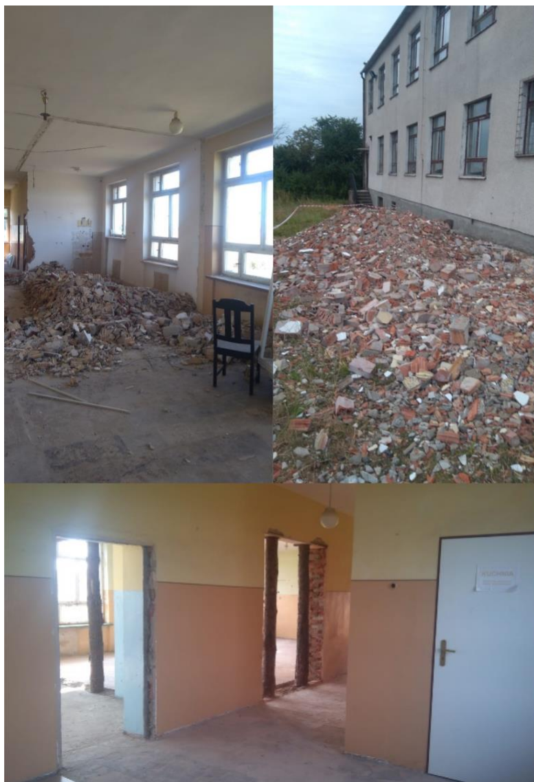
Ryc. 9. Budynek byłej szkoły podstawowej w sołectwie Orzelek – dokumentacja fotograficzna Źródło: Urząd Miejski w Kamieniu Krajeńskim
