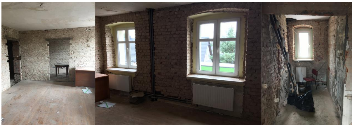
Ryc. 19. Budynek przy ul. Sępoleńskiej 6 od wewnątrz (1)
