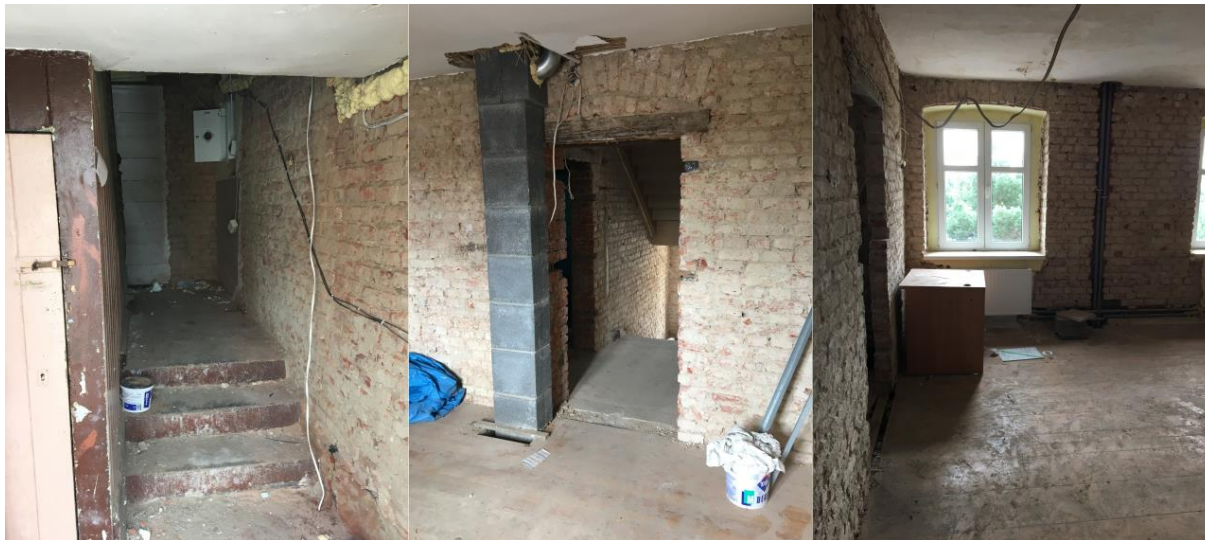
Ryc. 13. Budynek przy ulicy Sępoleńskiej 6 na obszarze JS2 – dokumentacja fotograficzna
