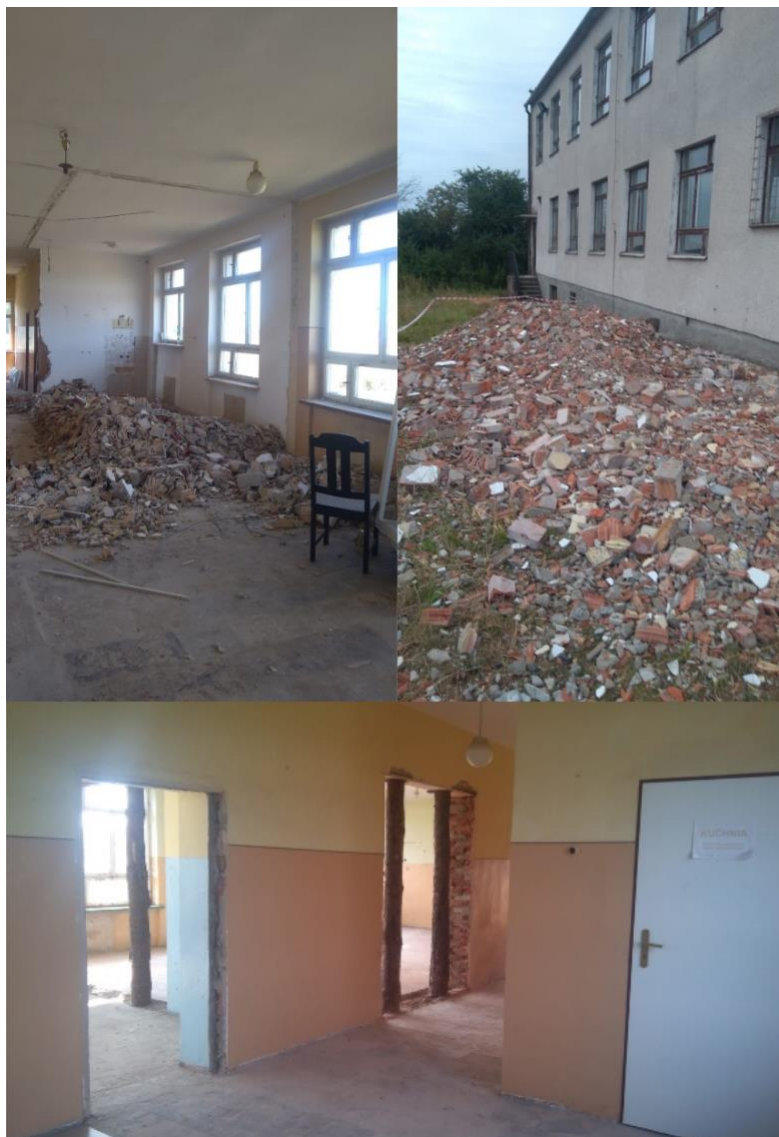
Ryc. 9. Budynek byłej szkoły podstawowej w sołectwie Orzełek – dokumentacja fotograficzna Źródło: Urząd Miejski w Kamieniu Krajeńskim
