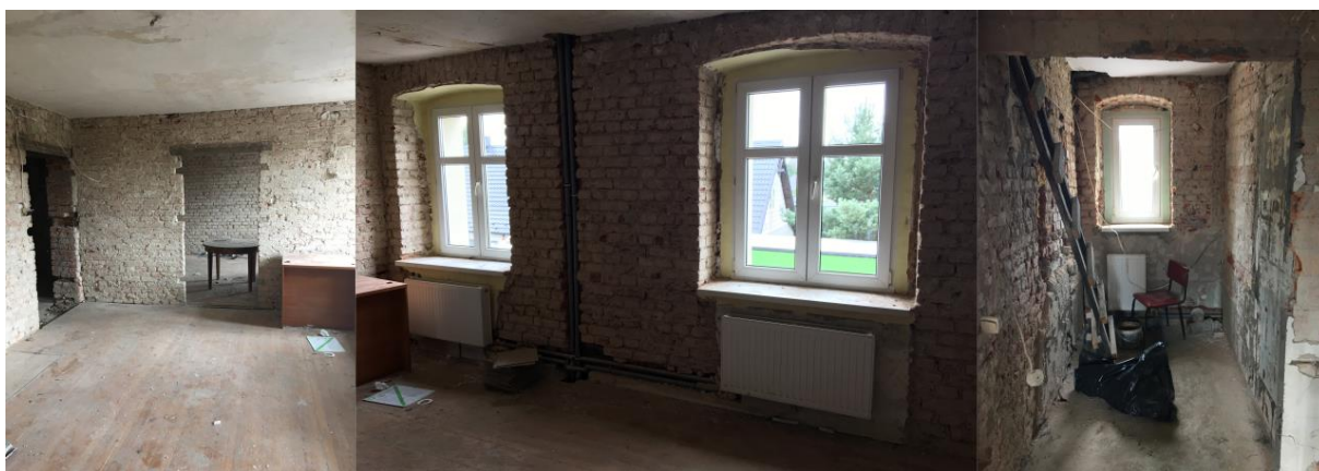
Ryc. 29. Budynek przy ul. Sępoleńskiej 6 od wewnątrz (1)
