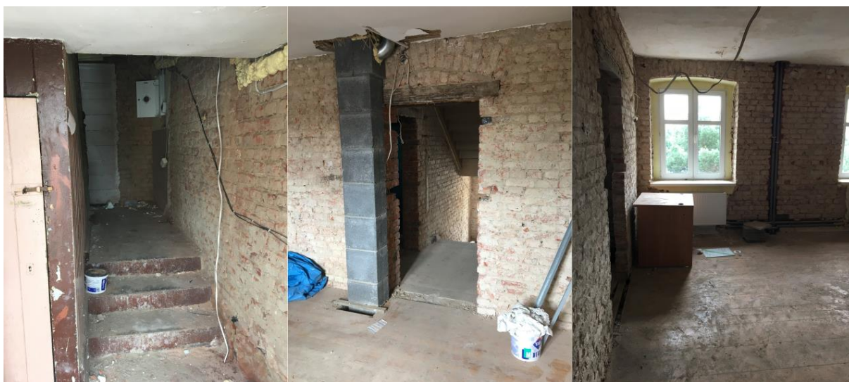
Ryc. 22. Budynek przy ulicy Sępoleńskiej 6 na obszarze JS2 – dokumentacja fotograficzna
