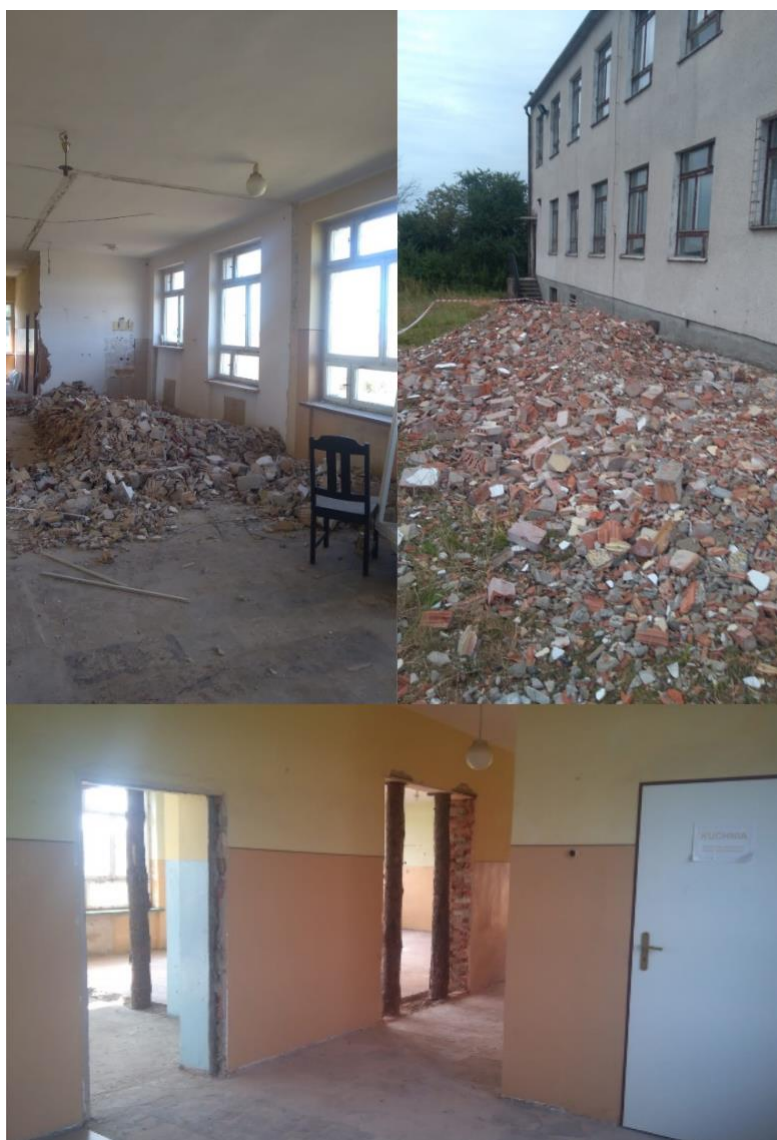
Ryc. 16. Budynek byłej szkoły podstawowej w sołectwie Orzełek – dokumentacja fotograficzna
