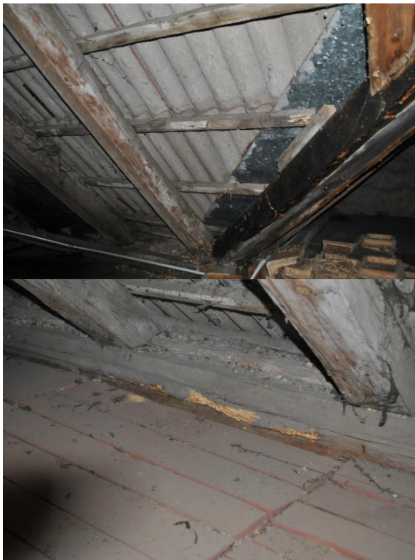
Ryc. 17. Budynek szkoły w sołectwie Płocicz – dokumentacja fotograficzna
