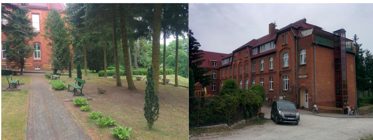
Ryc. 32. Budynek DPS i teren wokół
