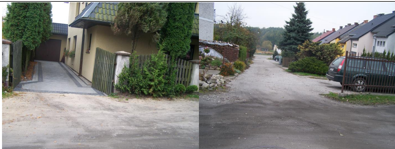
Wjazdy do posesji i na ulice łączące – ul. Spokojna
