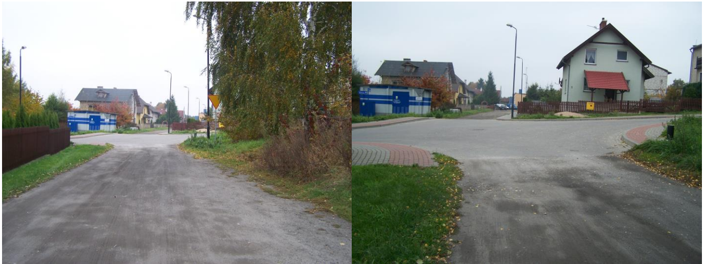
Widok na wjazd w ul. Słoneczną od strony wjazdu z ul. Spokojnej
