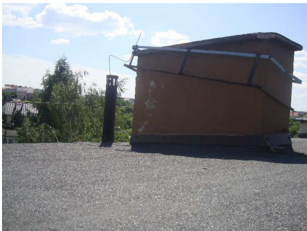
Instalacja odgromowa do remontu
