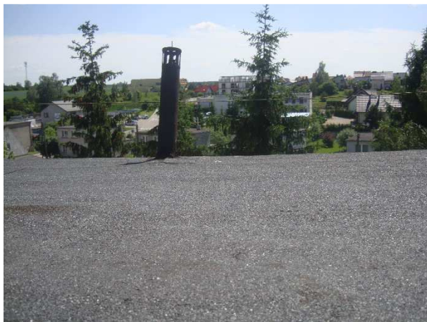
Dach pokryty papą
