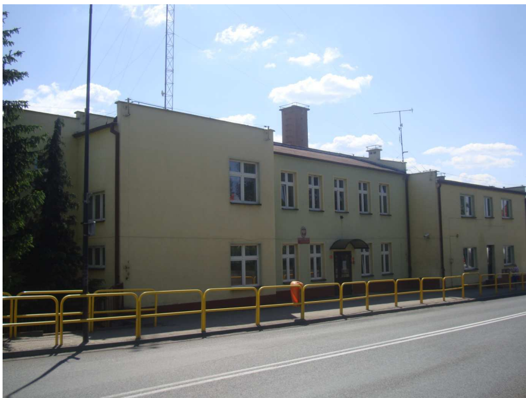
Widok na elewację frontową
