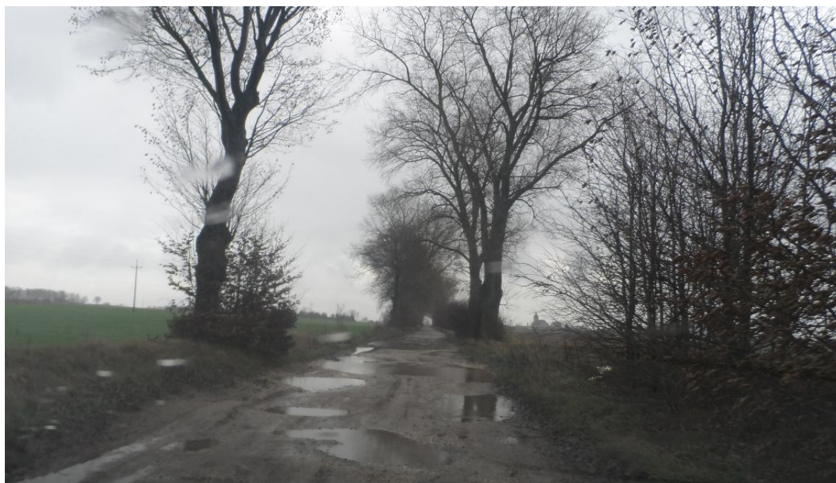
Fot. 1 Widok drogi gminnej w Płociczu
