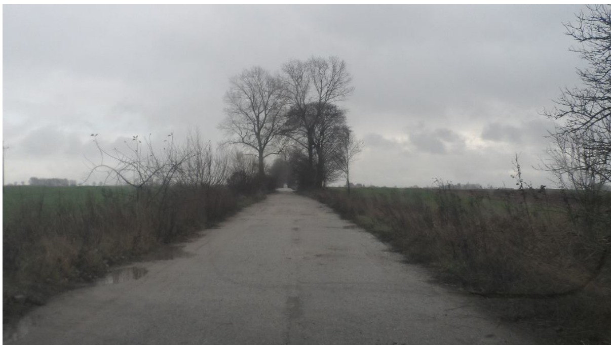
Fot. 2 Widok drogi gminnej w Płociczu
