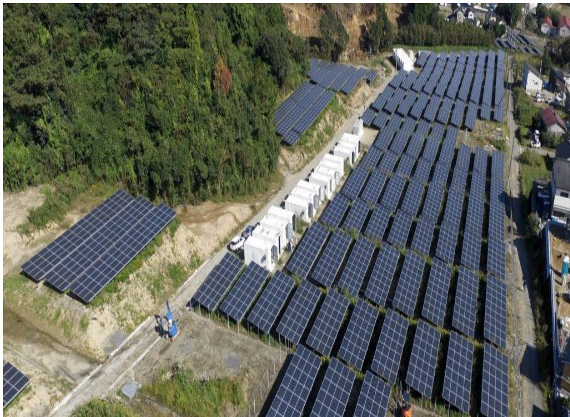
Fotografia 5 Farma fotowoltaiczna z systemem magazynowania energii.
