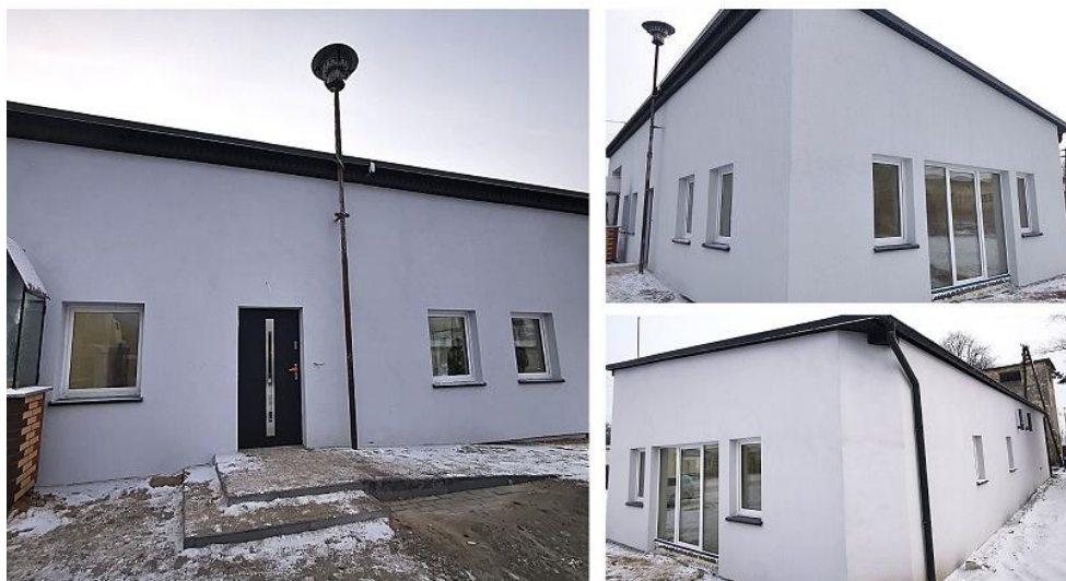
Stan po - budynek
