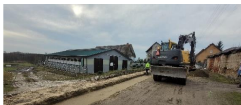
W trakcie robót
