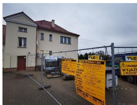
Przed rozpoczęciem robót
