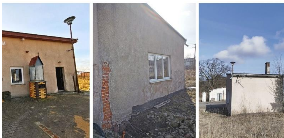
Stan przed - budynek
