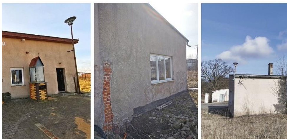
Stan przed - budynek
