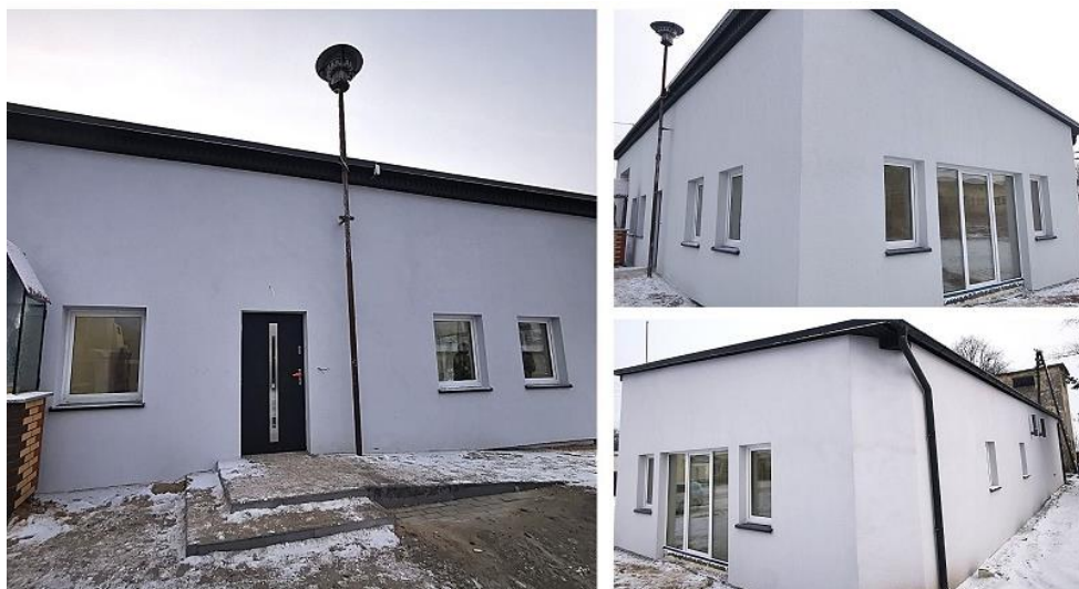
Stan po - budynek
