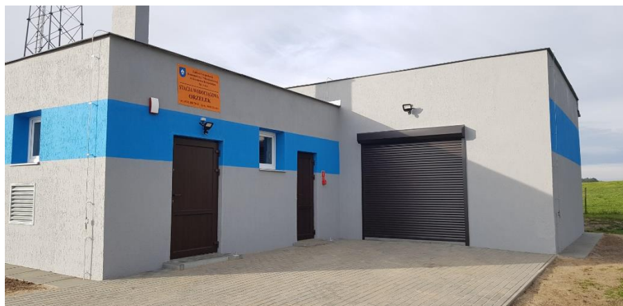
Stacja uzdatniania wody (tzw. SUW) w Orzełku, fot. ZGKiM
